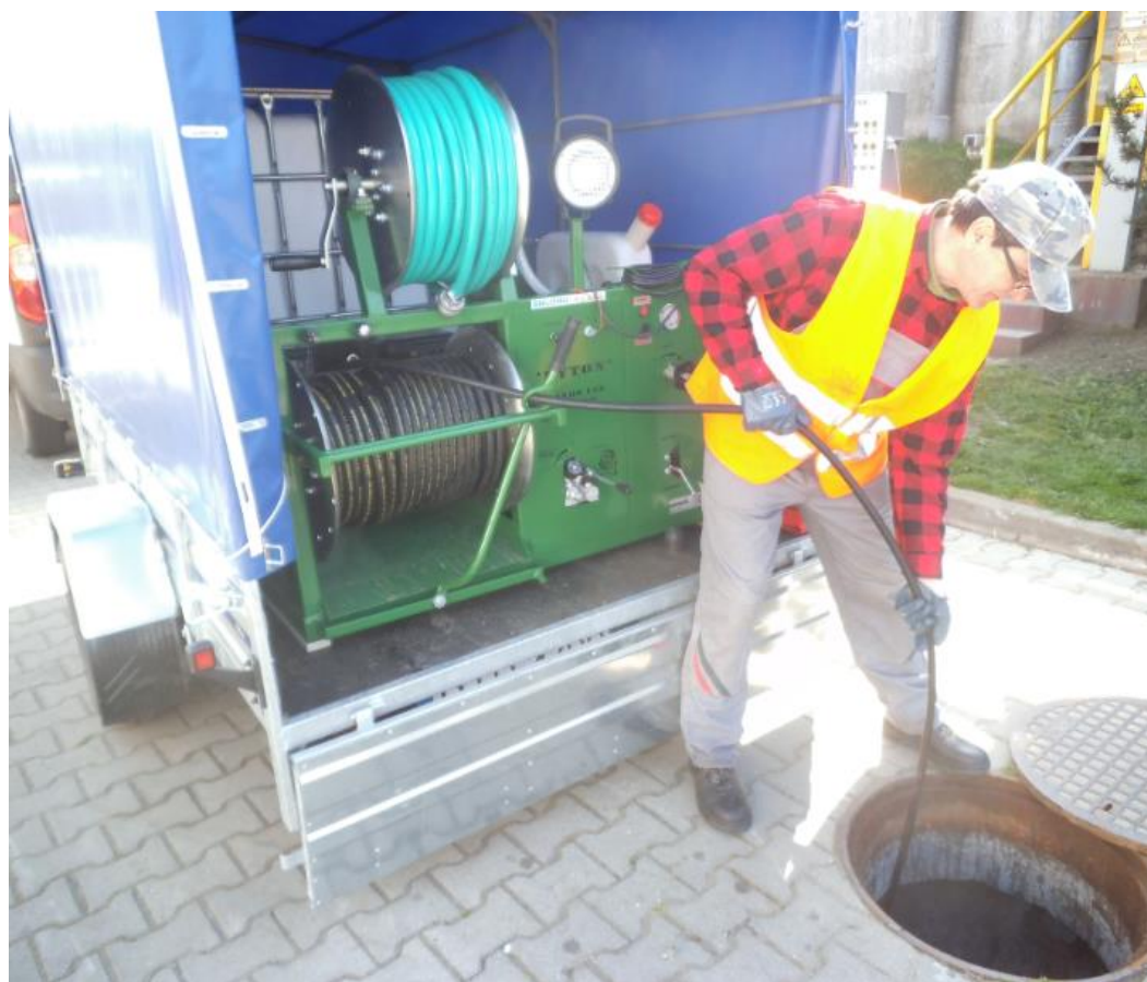
zdjęcie nr 2 – pracownik obsługujący przewoźne urządzenie ciśnieniowe do czyszczenia kanalizacji sanitarnej
